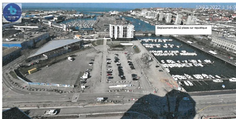
Bassin sauvage Pendant les travaux
